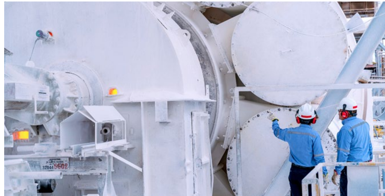
Planta de óxido de magnesio, Química del Rey
