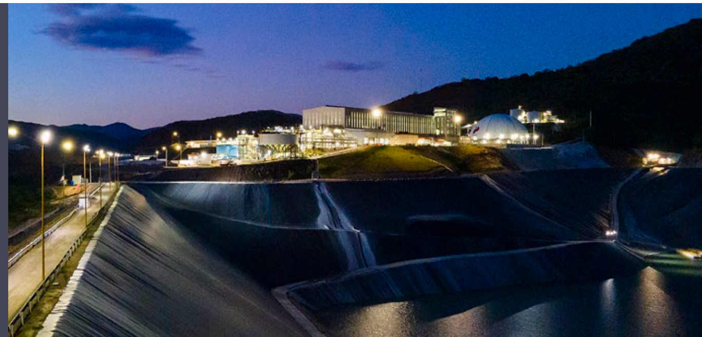
Panorámica, planta Capela
