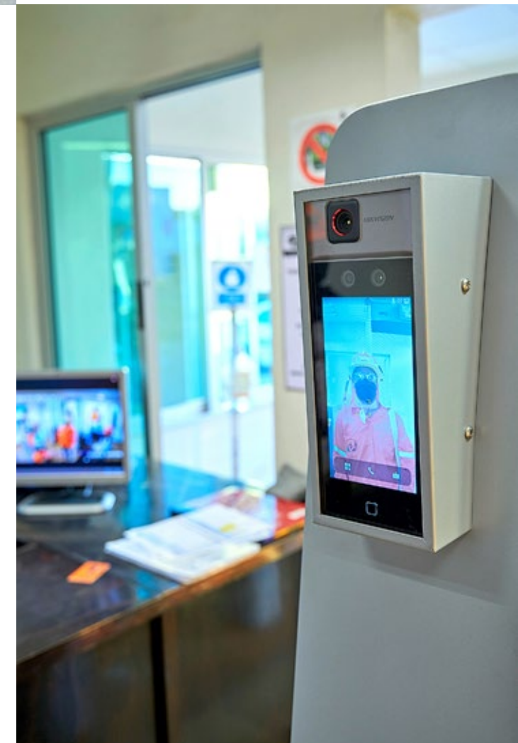
Monitoreo en el acceso, planta Tizapa
