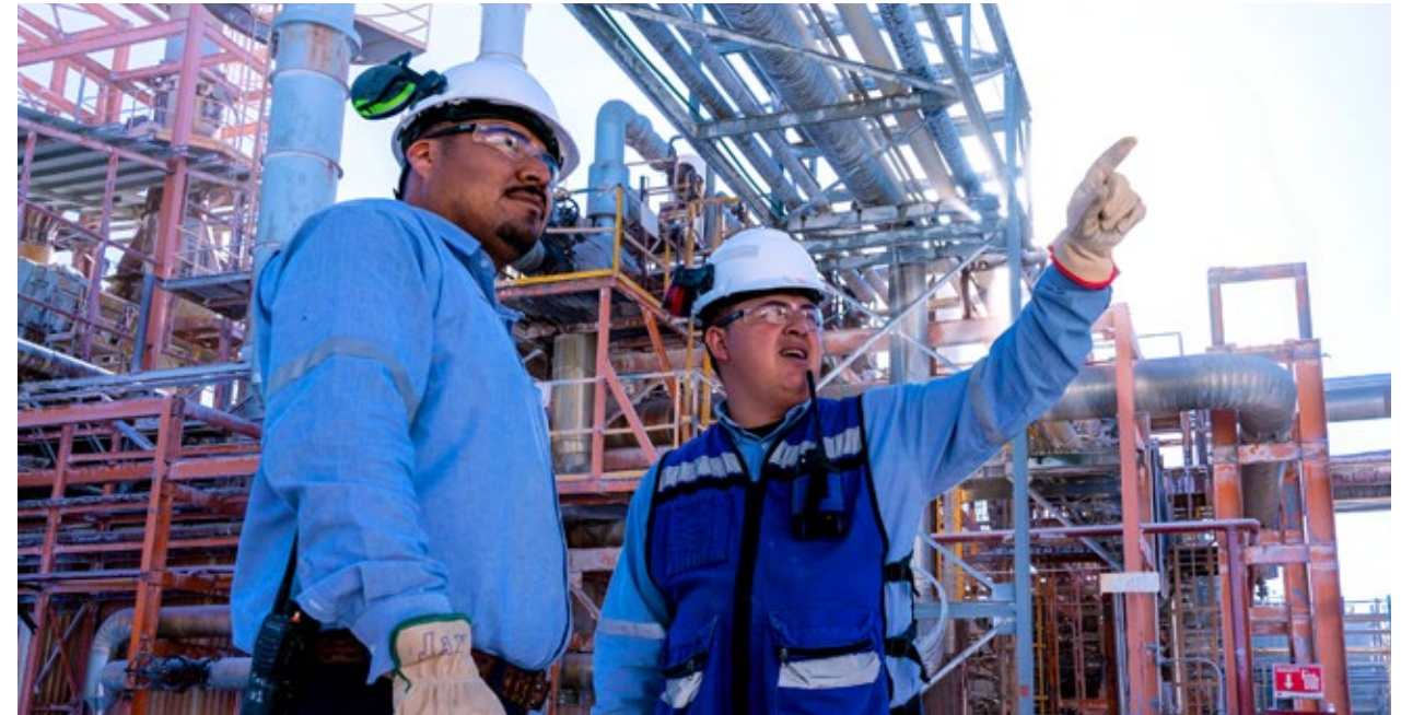
Planta de servicios generales, Química del Rey
